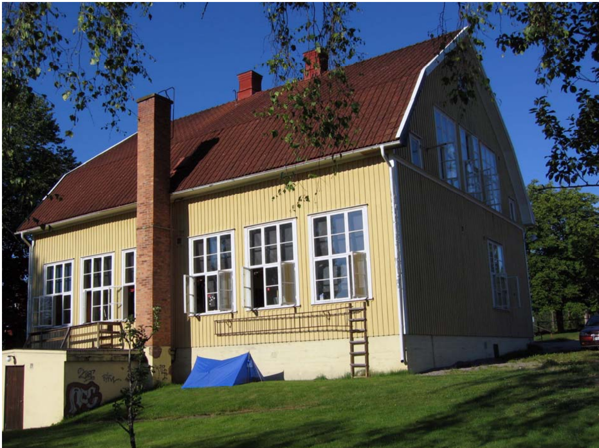
Trädgårdsfasad, ateljéfönster mot väster
